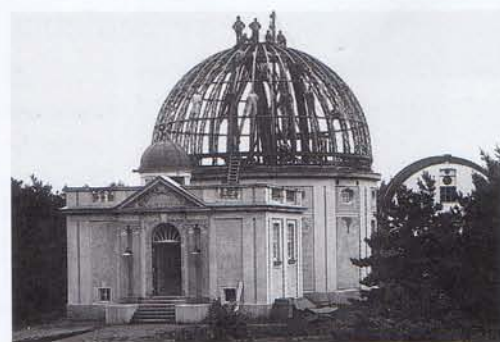
STAHLKONSTRUKTION Die Kuppeln, hier der Große Refraktor, wurden aus Stahl gefertigt, die Architektur der Gebäude im Stil des Neobarock. Foto: Sternwarte
